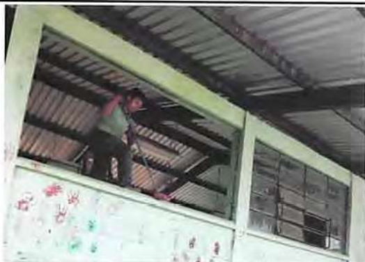
Foto1: Sustitución de ventanas por ventanas corredizas de PVC e instalación de balcones.
