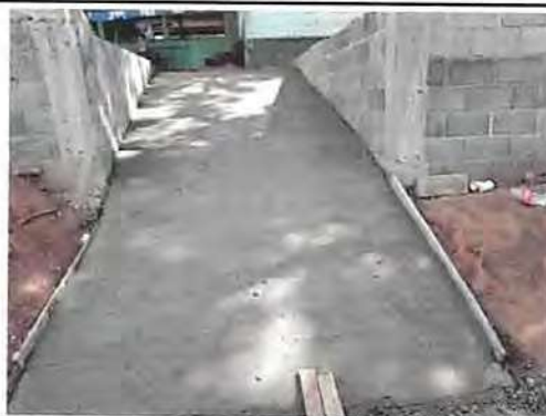
Foto 4: Sustitución de portón, instalación de estructura de techo, sustitución de gradas por rampa.
