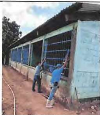
Foto 3: Sustitución de ventanas de paleta por ventanas corredizas de PVC e instalación de balcones (parte trasera)
