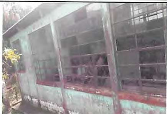
Foto1: Sustrución de ventanas por ventanas corredizas de PVC e instalación de balcones.
