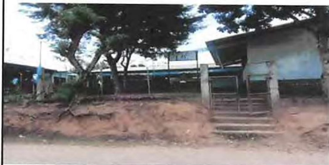
Foto 4: Sustrución de portón, instalación de estructura de techo, sustitución de gradas por rampa.
