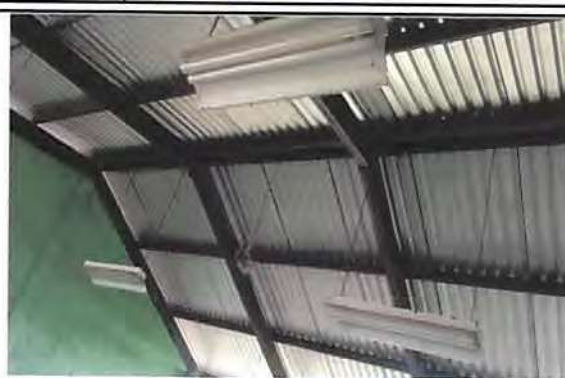
Foto 2: Reparación de sistema electrico.
