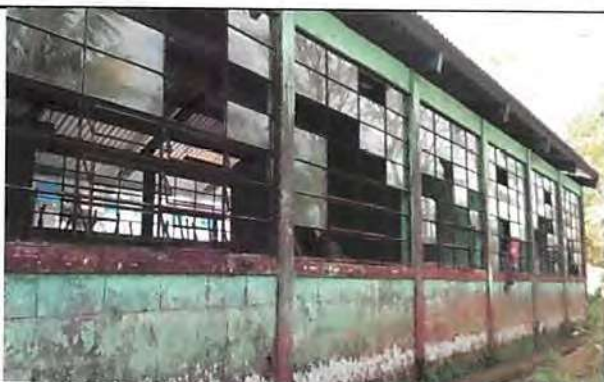
Foto 3: Sustrución de ventanas de paleta por ventanas corredizas de PVC e instalación de balcones (parte trasera)
