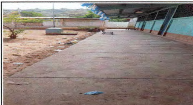
Foto 4: Instalación de piso granito
