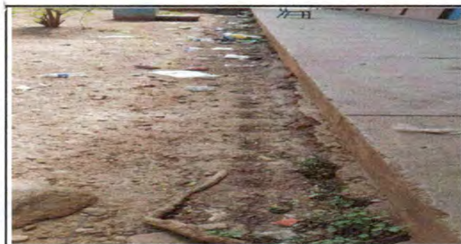
Foto 5: Reparación de losa de patio
