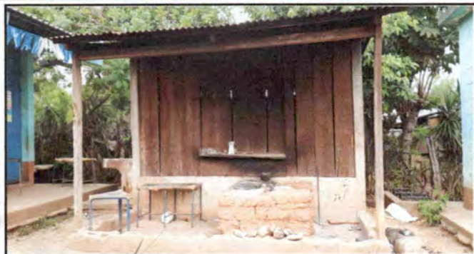
Foto 1: Reparación de cocina con block
