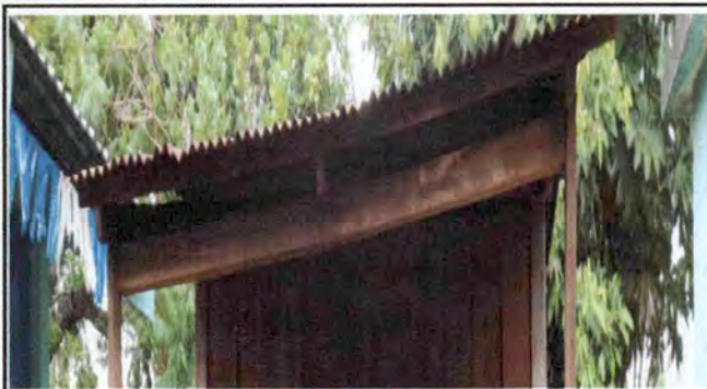
Foto 2: Sustitución de estructura de madera por metal
