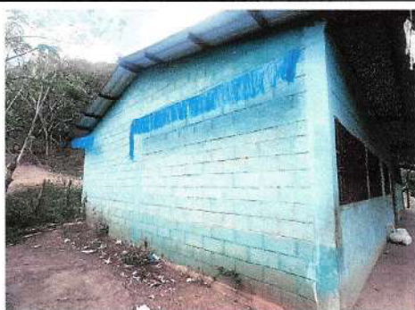
Foto 5: Pintura de las paredes el establecimiento
