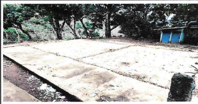
Foto 6: Reparación de losa de patio
