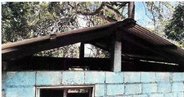
Foto 1: Sustrucción de lamina por lámina troquelada alucin calibre 25 8 pies
