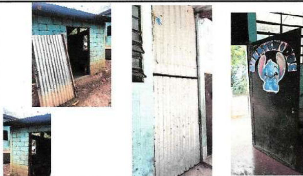
Foto 3: Sustrucción de puertas
