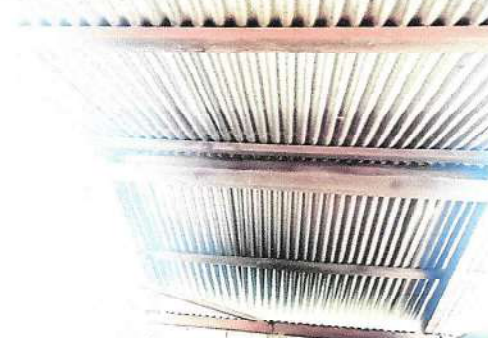
Foto 2: Sustrucción de costaneras de madera por estructura metalica
