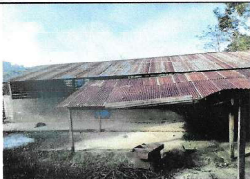
Foto 1: Sustrucción de cubierta de lámina.
