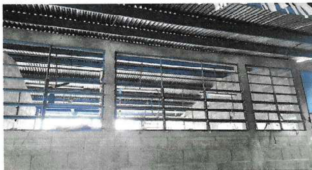
Foto 2: Reparación de ventanas.
