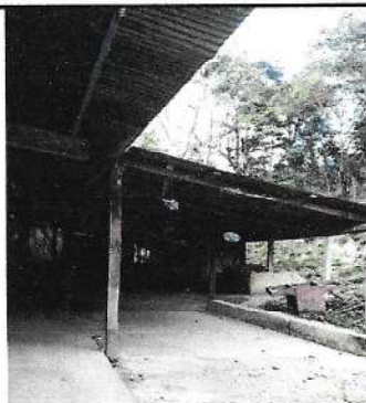
Foto 4: Sustrucción de estructura.
