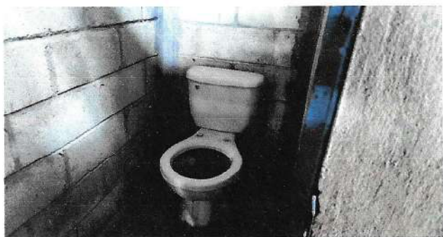
Foto 3: Sustrucción de servicios sanitarios.
