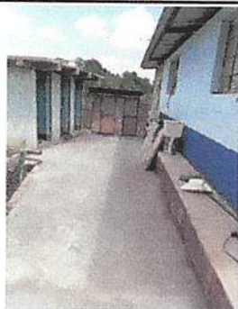
Foto 3: Continuación de losa de patio, instalación de pila prefabricada de dos lavaderos.
