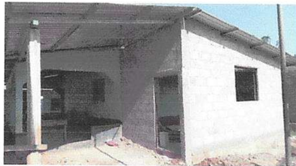
Foto 2: Continuación de pared de bodega, sustitución de puerta, instalación de ventanas, sustitución de lámina y estructura de techo.
