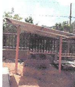
Foto 6: Sustitución de estructura de área de cocina y cambio de techo.
