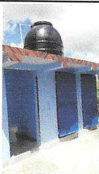
Foto 5: Reparación techo de baños para colocación de tinaco de agua.
