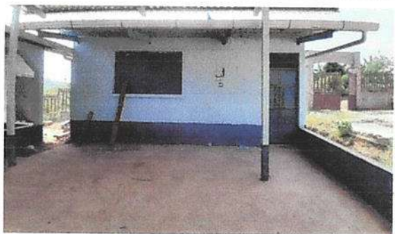
Foto 1: Sustitución de canales y reparación de bajadas de agua pluvial.
