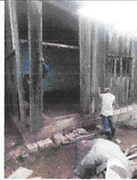
Foto 2: Continuación de pared de bodega, sustrucción de puerta, instalación de ventanas, sustrucción de lámina y estructura de techo.
