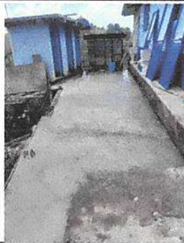
Foto 3: Continuación de losa de patio, instalación de pila prefabricada de dos lavaderos.
