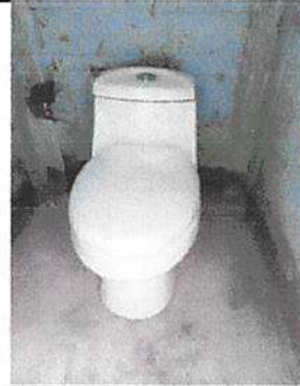
Foto 4: Reparación de accesorios y sustrucción de sanitarios
