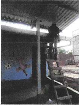
Foto 1: Sustrucción de canales y reparación de bajadas de agua pluvial.
