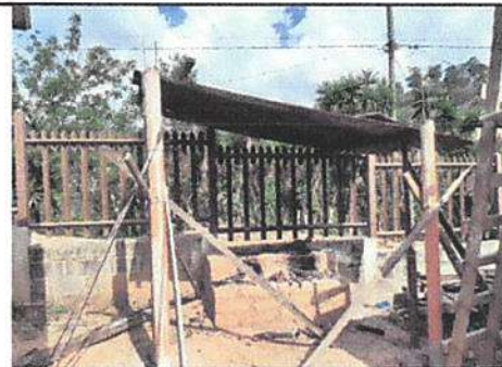
Foto 6: Sustrucción de estructura de área de cocina y cambio de techo.
