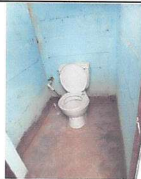
Foto 4: Reparación de accesorios y sustrucción de sanitarios.
