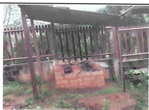
Foto 6: Sustrucción de estructura de cocina y cambio de techo.
