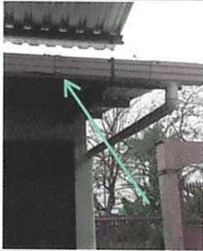
Foto 1: Sustrucción de canales y reparación de bajadas de agua pluvial.
