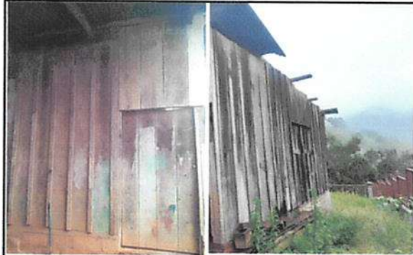
Foto 2: Continuación de pared de bodega, sustrucción de puerta, instalación de ventanas, sustrucción de lámina y estructura de techo.
