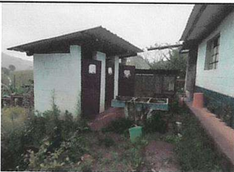
Foto 5: Reparación de techo de baños para colocación de tinaco de agua.
