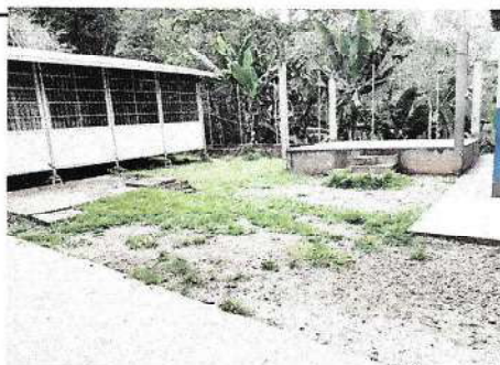
Reparación de losa de patio y cunetas
