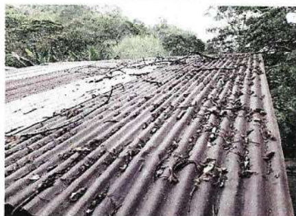
Sustitución de lámina por troquelada
