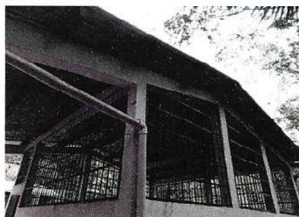
Reparación de entechado de cocina
