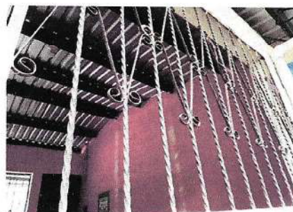
Instalación de ventanales
