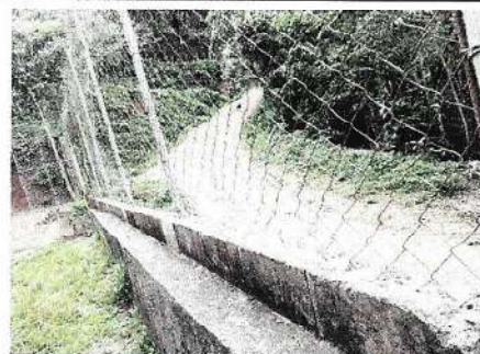
Reparación de muro perimetral
