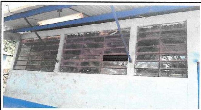
Foto 3: Sustitución de ventanales por ventanas de PVC.
