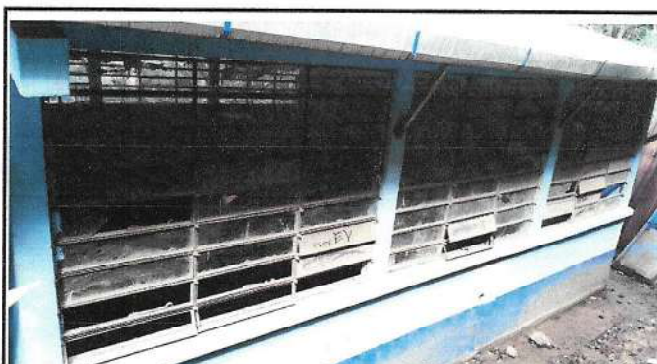
Foto 4: Instalación de balcones y sustitución de ventanales y puertas de PVC.
