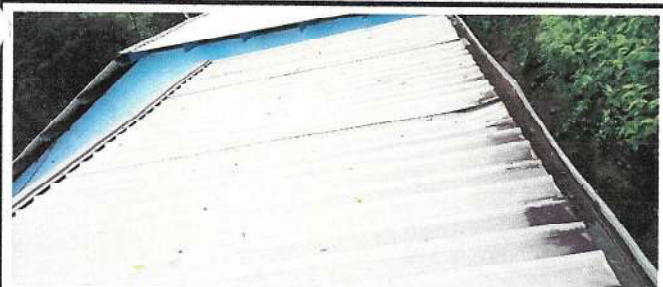
Foto 5: Sustitución de cubierta de lámina de aulas.
