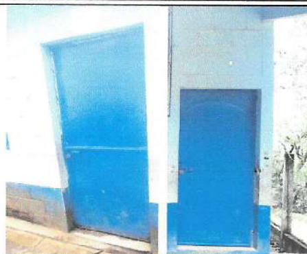
Foto 2: Sustitución y mantenimiento a puertas.
