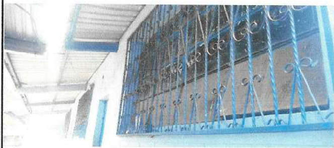
Foto1: Mantenimiento de balcones (cepillado, lijado y pintado)
