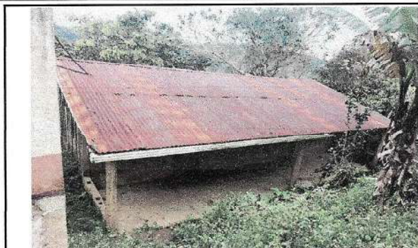
Foto1: Sustitución de lámina de techo.
