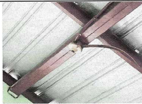
Foto 2: Reparación de sistema eléctrico.
