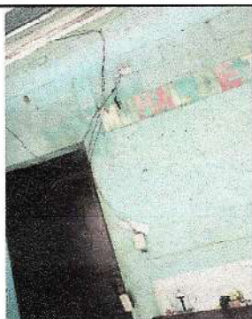
Foto 3: Sustitución de interruptores eléctricos y cableado de toda la escuela.
