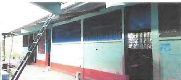
Foto 3: Instalación de balcones.
