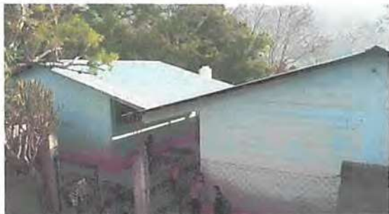
Foto 1: Sustitución de lámina.
