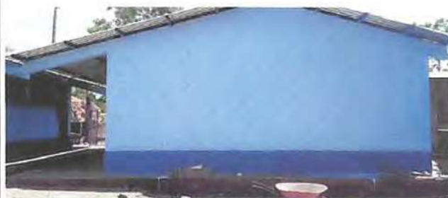
Foto 4: Pintura de muros exteriores.
