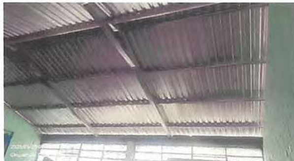
Foto 2: Sustitución de estructura de techo.
