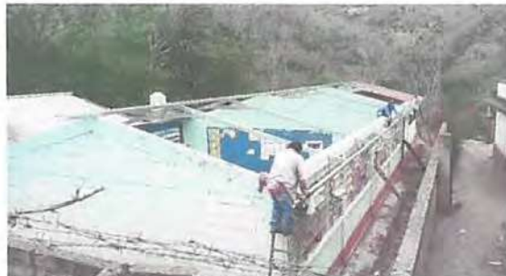
Foto 2: Sustrucción de estructura de techo.
