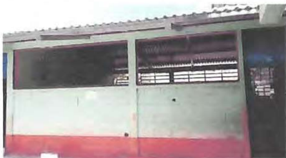
Foto 3: Instalación de balcones.
