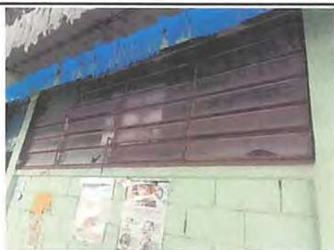
Foto 3: Instalación de balcones.
