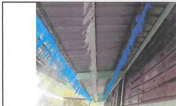
Foto 1: Sustitución de lámina.
