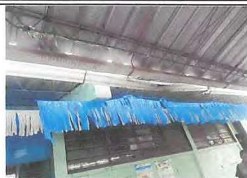
Foto 2: Sustitución de estructura de techo.
