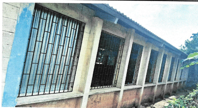
Foto 5: INSTALACIÓN DE VENTANAS
