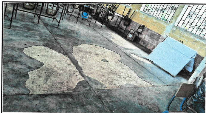
Foto 4: SUSTITUCIÓN DE TORTA DE CEMENTO POR PISO.
