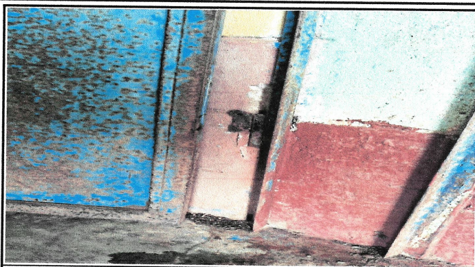
Foto 2: REPARACIÓN Y MANTENIMIENTO DE PUERTA
