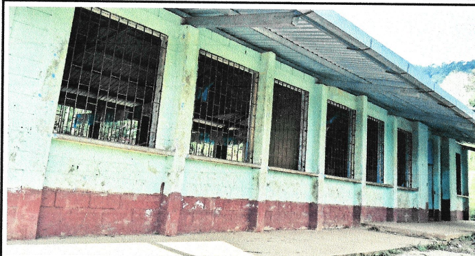
Foto1: PINTURA EN MURO EXTERIOR E INTERIOR
