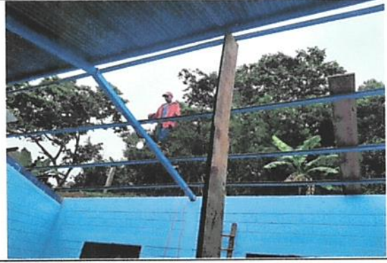
Foto 2: Sustitución de lámina de techo.
