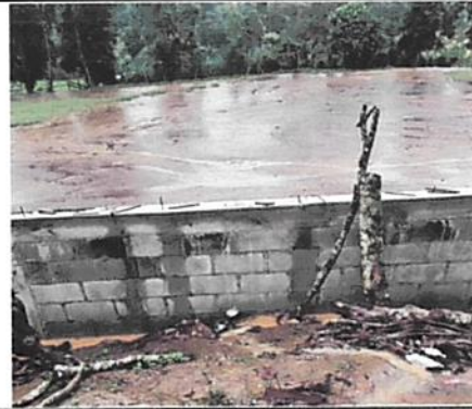
Foto 4: Continuación de muro perimetral y sustitución de maya.
