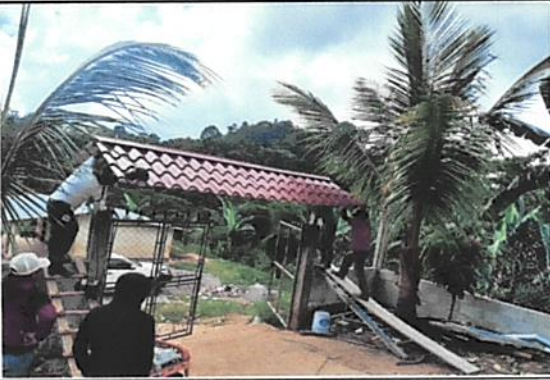
Foto1: Sustitución de portón e instalación de techo.
