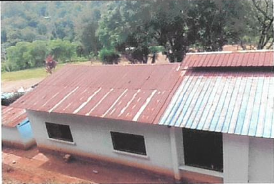
Foto 2: Sustrucción de lámina de techo.
