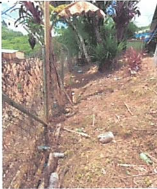
Foto 4: Continuación de muro perimetral y sustrucción de maya.
