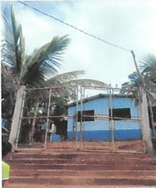
Foto1: Sustrucción de portón e instalación de techo.
