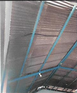
Foto 3: Mantenimiento a estructura metálica de techo.
