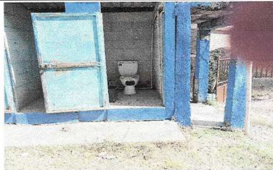
Foto 4: Sustitución de baño.
