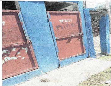
Foto 2: Reparación de puertas.
