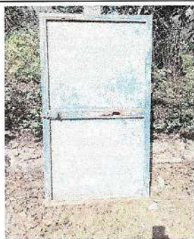
Foto 3: Sustitución de puerta.
