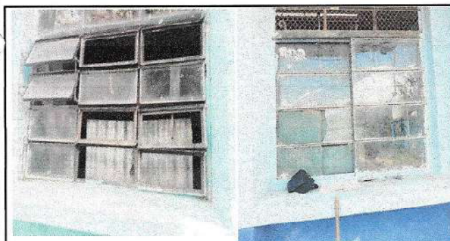
Foto 5: Elaboración de balcones.
