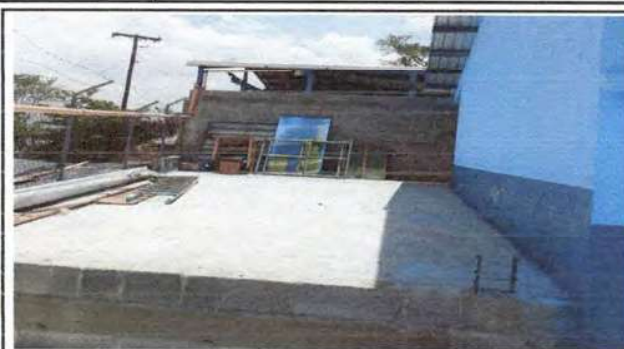
Foto 2: Losa de patio
