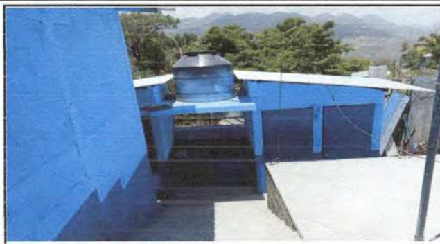
Foto 88: Mantenimiento de sanitarios y sus estructuras
