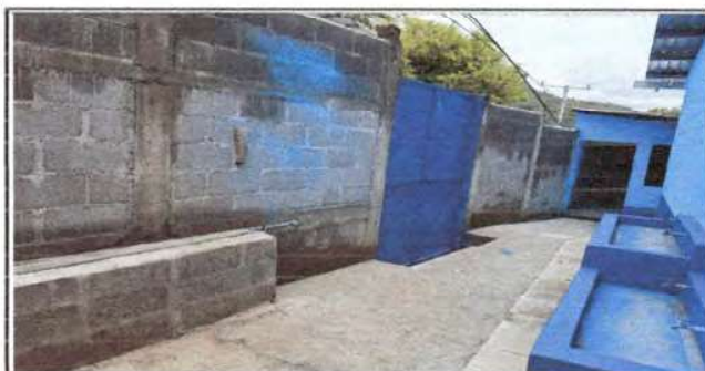
Foto 5: Reparación de muro perimetral
