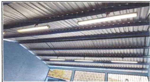
Foto 10: Reparación del sistema electrico
