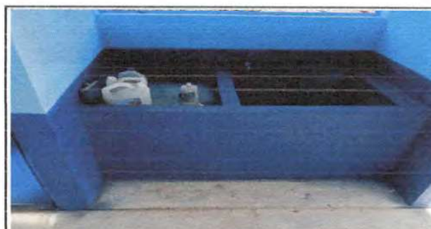
Foto 6: Reparación de deposito de agua
