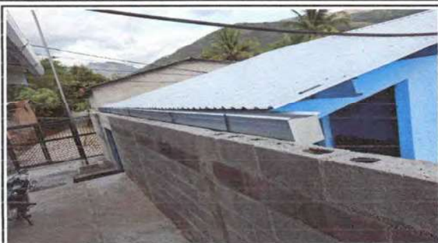
Foto7: Instalacion de canales y bajada de agua
