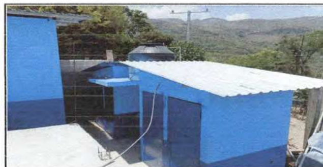
Foto 6: Reparación de sanitarios y aplicación de pintura
