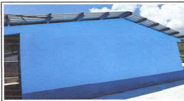
Foto 9: Pintura en muros exteriores e interiores
