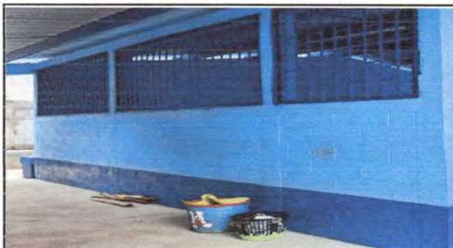
Foto 3: Instalación d balcones
