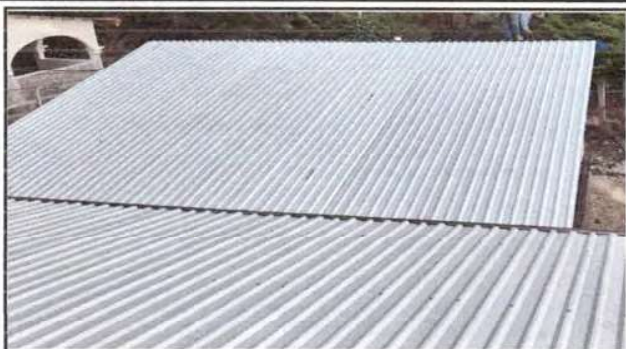
Foto1: Cubierta de Lamina
