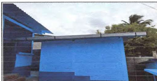
Foto 5: Pintura en muros exteriores
