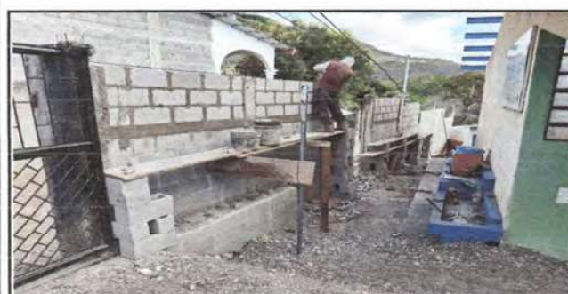
Foto 5: Reparación de muro perimetral
