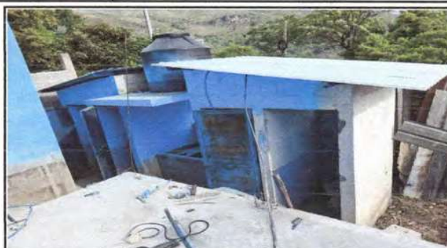
Foto 88: Mantenimiento de sanitarios y sus estructuras
