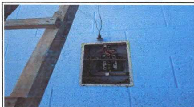
Foto 10: Reparación del sistema eléctrico
