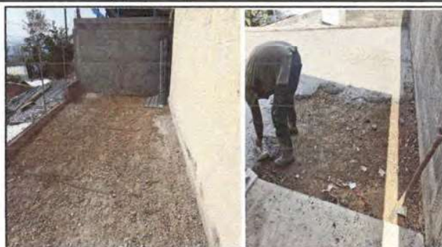
Foto 2: Losa de patio
