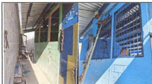
Foto 3: Instalación d balcones
