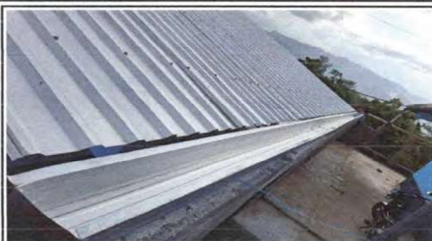
Foto 7: Instalación de canales y bajada de agua
