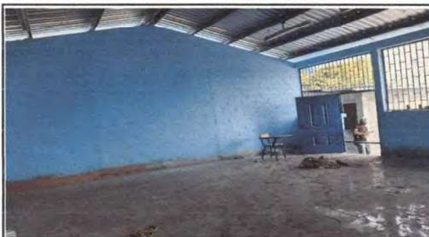
Foto 9: Pintura en muros exteriores e interiores
