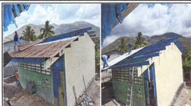
Foto1: Cubierta de Lamina
