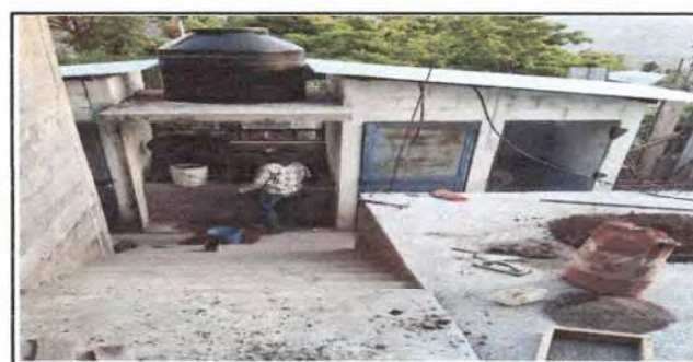
Foto 6: Reparación de deposito de agua
