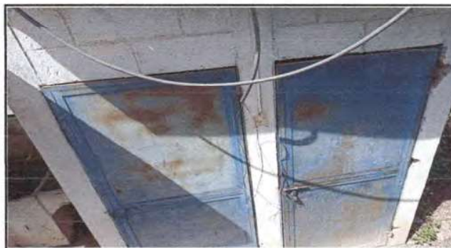
Foto 10: Reparación del sistema electrico
