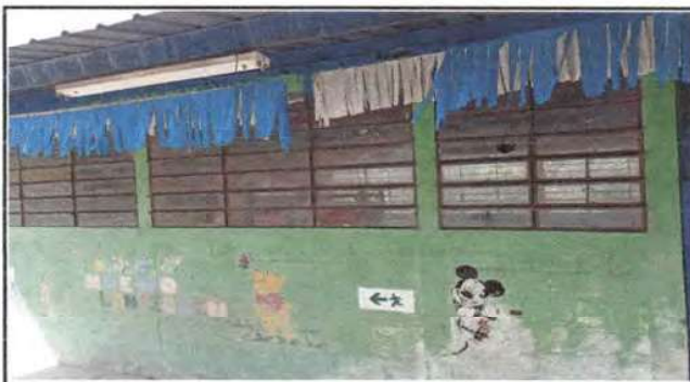
Foto 3: Instalación d balcones
