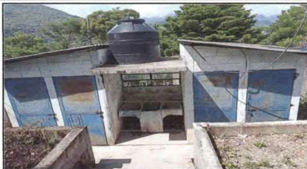
Foto 88: Mantenimiento de sanitarios y sus estructuras
