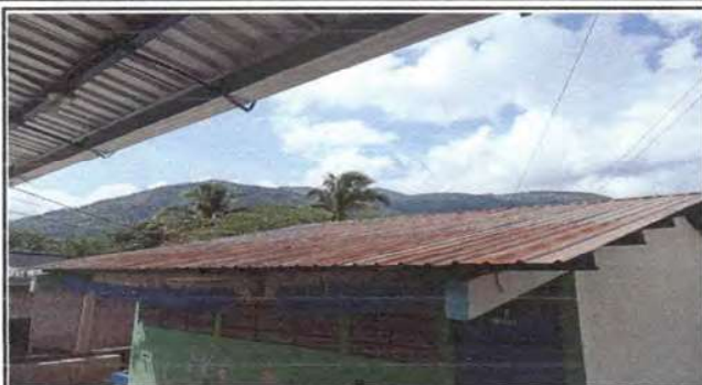
Foto 7: Instalacion de canales y bajada de agua
