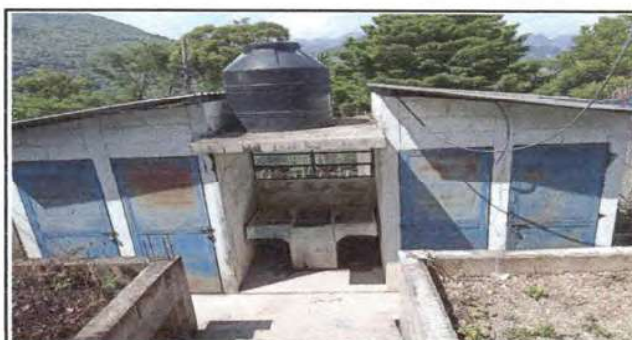
Foto 6: Reparación de deposito de agua
