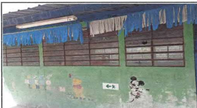
Foto 9: Pintura en muros exteriores e interiores
