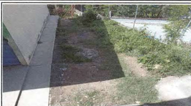
Foto 2: Losa de patio
