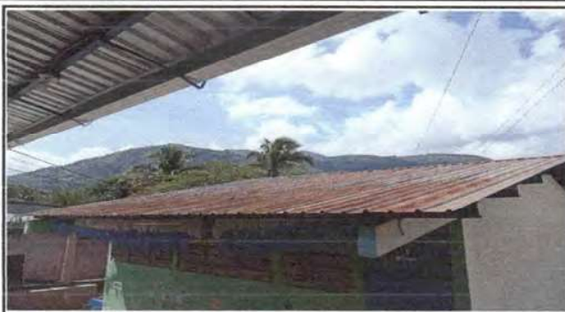
Foto1: Cubierta de Lamina
