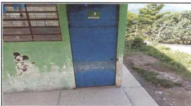
Foto 4: Sustitución de puerta antigua por apuerta nueva de paneles)
