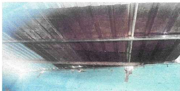
Foto1: MANTENIMEINTO DE COCINA
