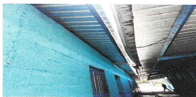
Foto 6: MANTENIMIENTO A CANALES
