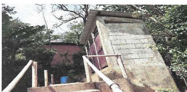
Foto 5: MANTENIMIENTO DE SERVICIOS SANITARIOS
