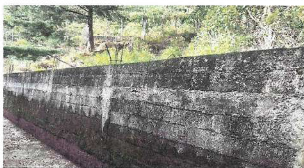
Foto 3: REPARACION DE MURO PERIMETRAL
