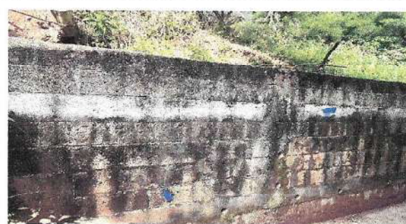
Foto 4: CONTINUACIÓN DE MURO PERIMATRAL
