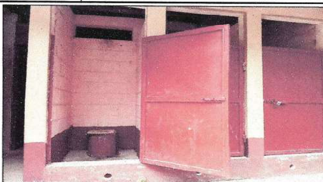
SUSTITUCION DE 3 SANITARIOS
