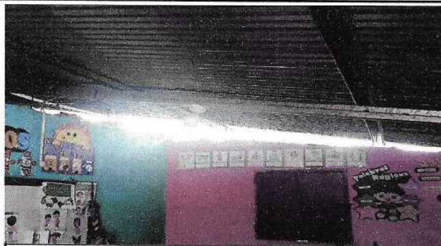
DISINSTALACION DE LAMINA EXISTENTE, COLOCACION DE BLOCK E INSTALACION DE LAMINA
