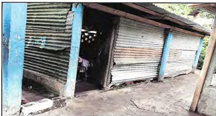
Foto 3: se observan las columnas de la pared No. 3
