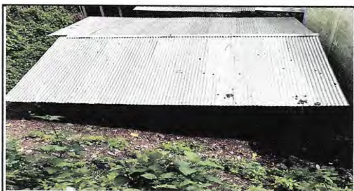
Foto 5: así se observa la cubierta de lámina del salon de la escuela
