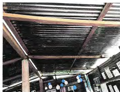
Foto 4: se observa las estructura del techo de madera del salon de la escuela.
