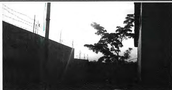
Foto 3: REPARACION Y REMOZAMIENTO DE MURO PERIMETRAL
