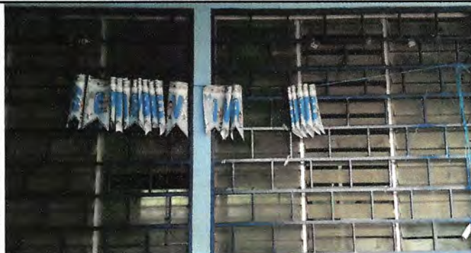
Foto 2: CAMBIO DE VENTANAS DE PERCIANA POR VENTANAS DE PVC
