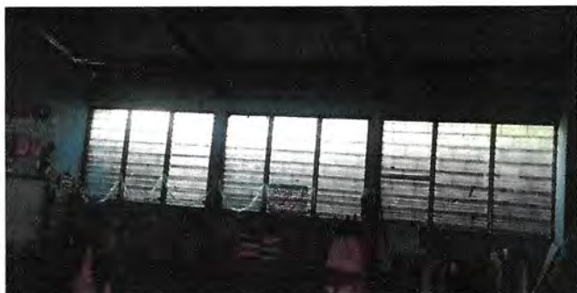
Foto1: CAMBIO DE VENTANAS DE PERCIANA POR VENTANAS PVC
