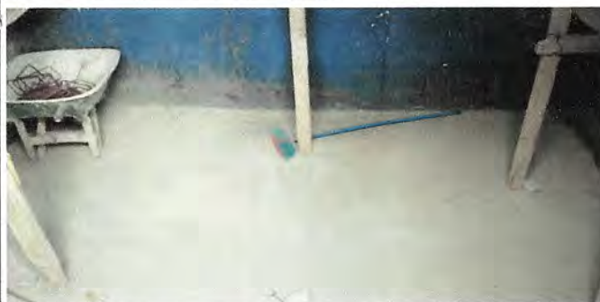
Foto 5: CAMBIO DE PISO DE CEMENTO POR PISO CERAMICO E INSTALACIÓN DE LUZ.
