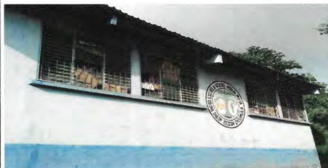
Foto 6: RENOVACIÓN DEL SISTEMA ELECTRICO DE TODO EL ESTABLECIMIENTO, Y CAMBIO DE VENTANAS
