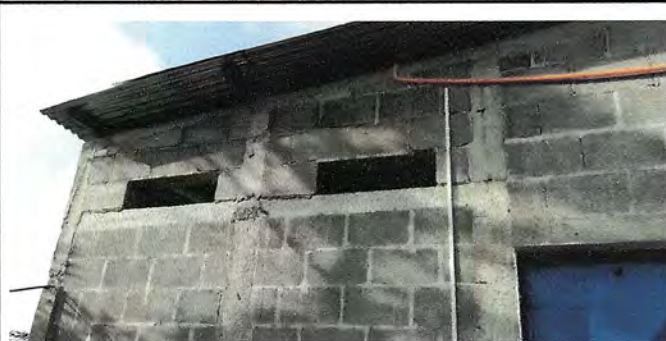
Foto 4: CERNIDO DE PAREDES, COLOCACIÓN DE VENTANAS E INSTALACIÓN DE LUZ.
