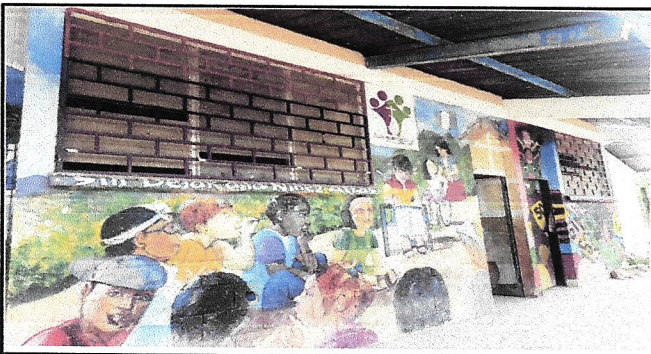
Foto 5: PINTURA DE MUROS EXTERIORES
