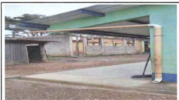
Foto 3: Canales y bajadas de agua pluvial
