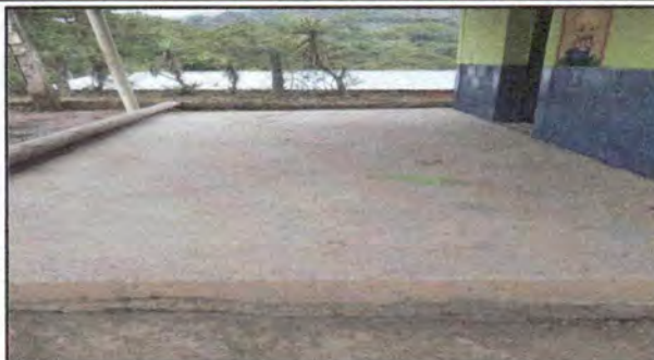
Foto 2: PISO sustitución de torta de concreto por granito
