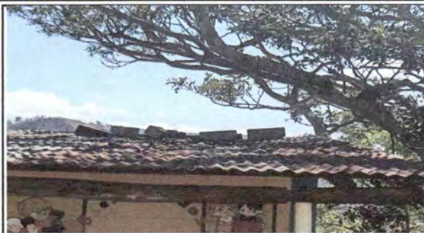
Foto1: CUBIERTA DE LÁMINA sustitución de lámina por lámina troquelada, sustitución de estructura de soporte de madera
