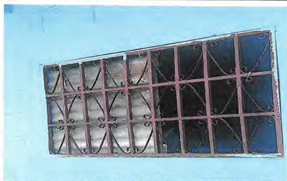
Foto 5: sustustrucción de ventanas y mantenimiento de balcones
