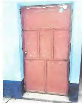
Foto 4: Sustrucción de chapas y mantenimiento de puertas
