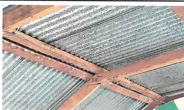
Foto 6: Reparación de cableado eléctrico
