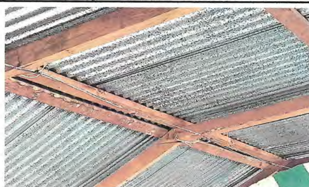
Foto 2: Sustrucción de estructura de soporte
