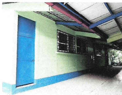
Foto 2: Pintura de muros interiores y exteriores remozada
