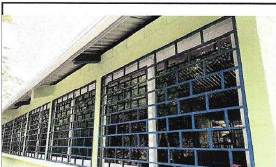
Foto 3: Mantenimiento de balcones y sustitución de ventanas
