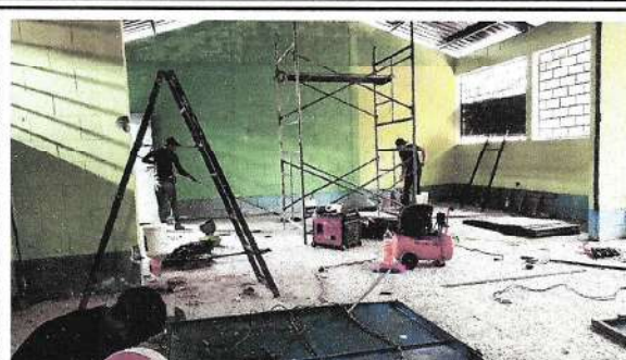
Foto 2: Pintura de paredes interior y exterior
