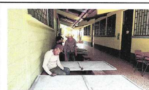
Foto 4: Mantenimiento de puertas
