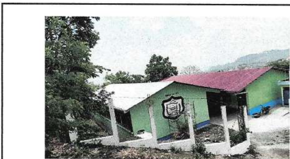
Foto 5: Sustitución de láminas
