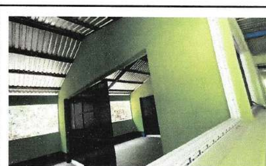
Foto 6: Mantenimiento de portones
