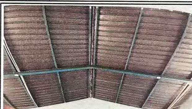
Foto 2: Mantenimiento de estructura
