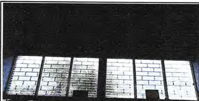
Foto 5: Sustrucion de 6 ventanas
