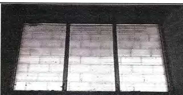
Foto 6: Sustrucion de 1 ventana
