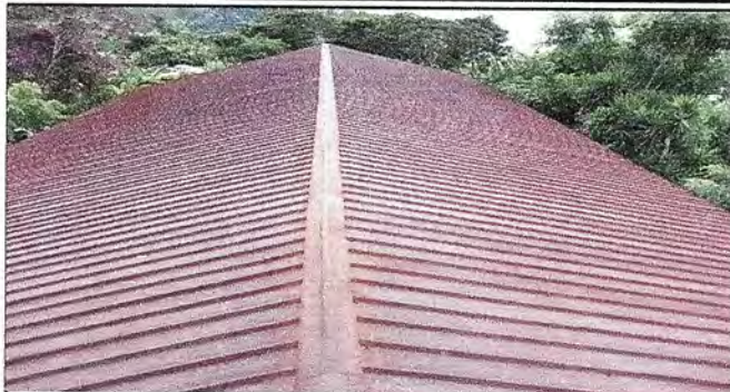
Foto 1: Sustrucion de la por lamina troquelada
