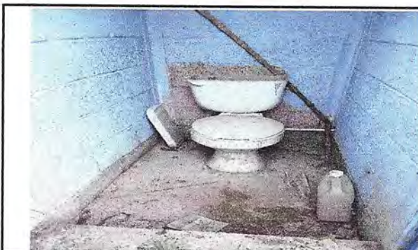
Foto 3: Sustrucion de baño y de torta de cemento
