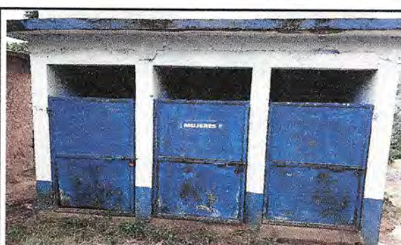
Foto 4: Sustrucion de puertas de los baños
