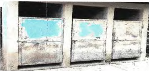
Mantenimiento de las puertas del baño
