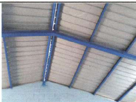
Foto 5: Estructura del techo del centro educativo remozada
