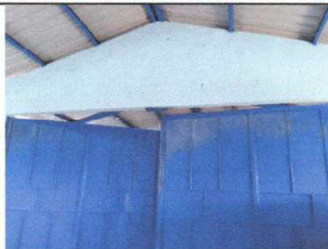
Foto 2: Estructura de las divisiones de las aulas remozada
