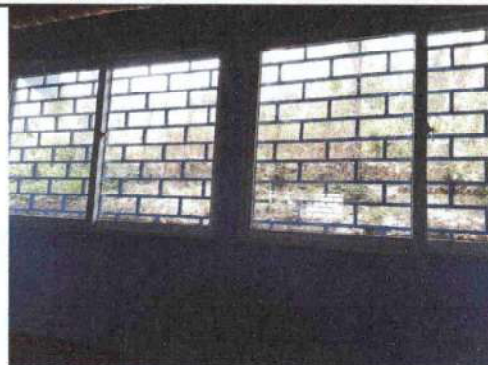
Foto 2: Balcones y ventanas remozadas
