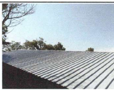
Foto 6: Láminas del techo remozadas
