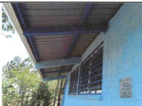
Foto 3: Canales de captación de agua de lluvia remozado
