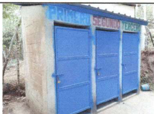
Foto 4: Puertas de los servicios sanitarios remozadas
