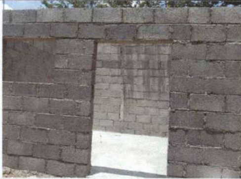
Foto 1: Sustituyendo paredes de la cocina
