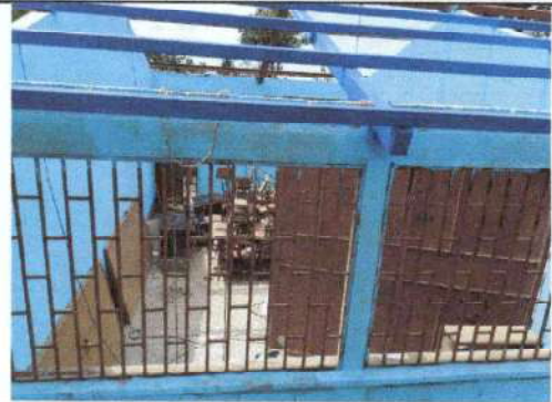
Foto 2: Dando mantenimiento a balcones de las ventanas
