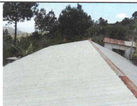
Foto 4: Dando mantenimiento a láminas del techo del centro educativo.
