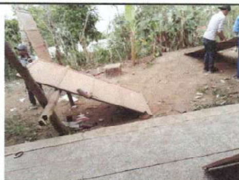
Foto 6: Dando mantenimiento a las puertas
