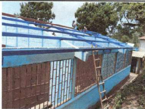
Foto 3: Dando mantenimiento a estructura del techo del centro educativo
