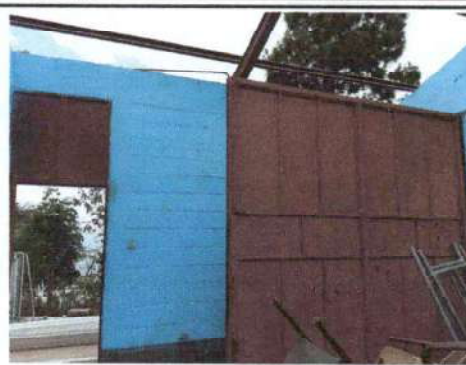
Foto 2: Dando mantenimiento a la estructura del techo
