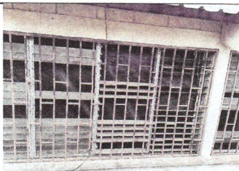
Foto 6: Sustitución de balcones y persianas de las ventanas
