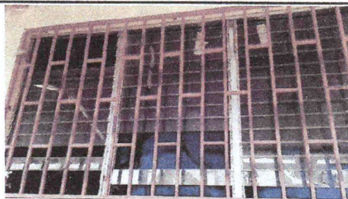
Foto 4: Sustitución de balcones y persianas de las ventanas
