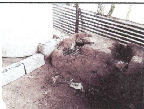
Foto 5: Sustitución de hornilla de la cocina
