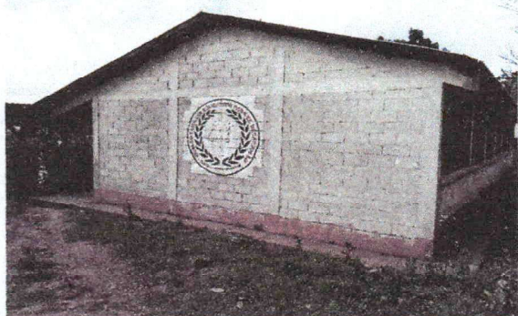
Foto1: Pintura de las paredes del centro educativo
