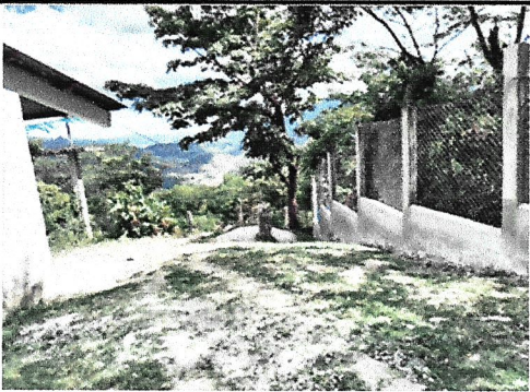
Foto 1: SEGUIMIENTO DE MURO PERIMETRAL
