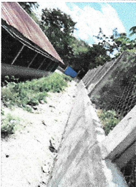
Foto 5: REFUERZO Y REMOZAMIENTO DE MURO EXISTENTE
