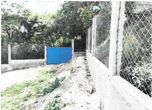
Foto 3: EFUERZO Y REMOZAMIENTO DE MURO EXISTENTE
