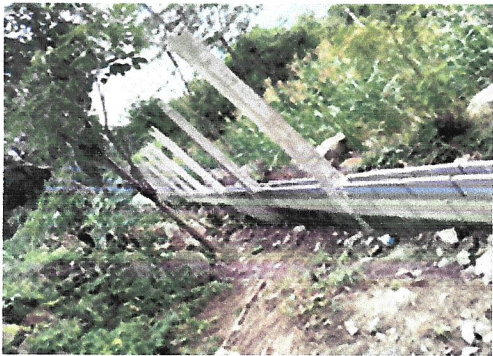
Foto1: SEGUIMIENTO DE MURO PERIMETRAL
