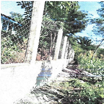
Foto 5: REFUERZO Y REMOZAMIENTO DE MURO EXISTENTE
