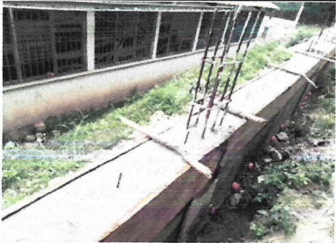
Foto 3: EFUERZO Y REMOZAMIENTO DE MURO EXISTENTE
