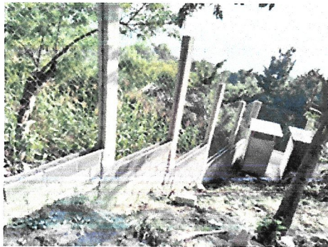
Foto 6: SEGUIMIENTO DE MURO EXISTENTE
