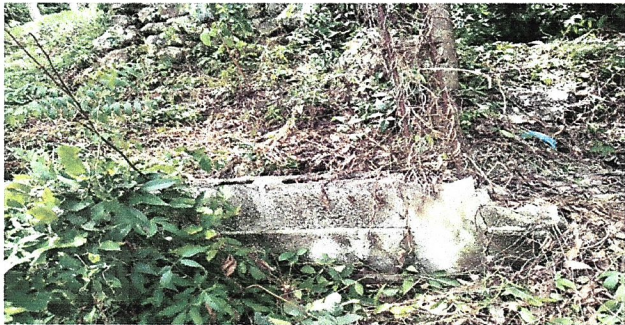
Foto 3: EFUERZO Y REMOZAMIENTO DE MURO EXISTENTE
