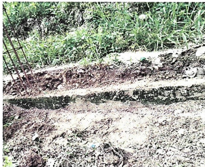
Foto 6: SEGUIMIENTO DE MURO EXISTENTE
