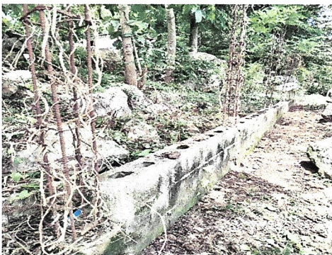
Foto 5: REFUERZO Y REMOZAMIENTO DE MURO EXISTENTE
