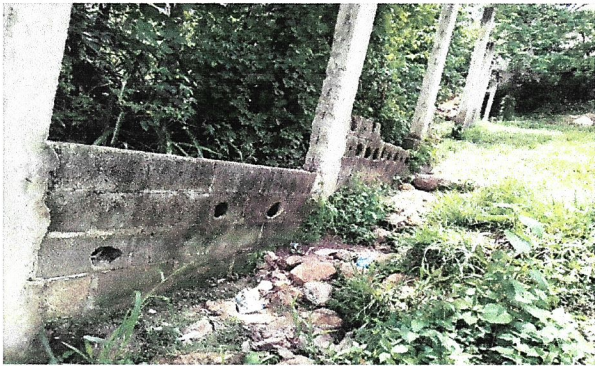
Foto1: SEGUIMIENTO DE MURO PERIMETRAL
