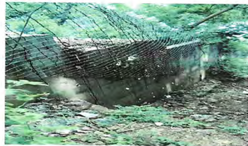
Foto 4: refuerzo de muro perimetral
