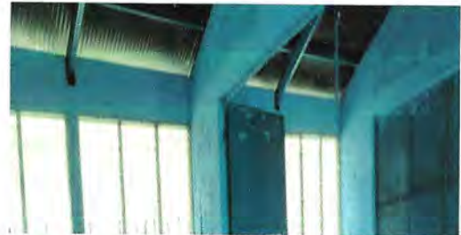
remozamiento de pintura en la estructura instalada
