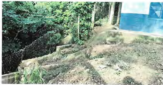
Foto 3: reparacion de muro perimetral
