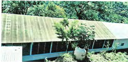
Foto 1: sustitución de cubierta de lamina por lamina troquelada
