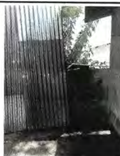
Foto 6: Reparación de 5 metros de muro perimetral. El muro es un peligro latente para la integridad física de los estudiantes.
