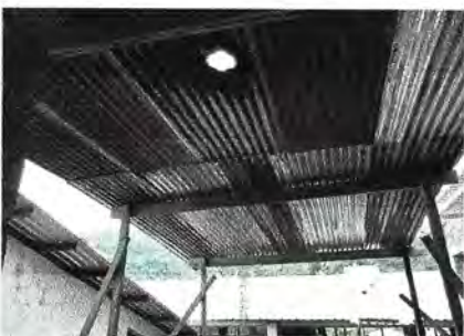
Foto 1: Sustrucción de 35 metros de estructura y lámina troquelada. La galera se encuentra en malas condiciones para que las y los estudiantes puedan refaccionar de forma segura.
