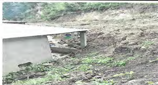
Foto 5:ÁREA AFECTADA POR SOCABAMIENTO Y DESLAVE DE TIERRA DURANTE LA LLUVIA QUE AFECTO PARED
