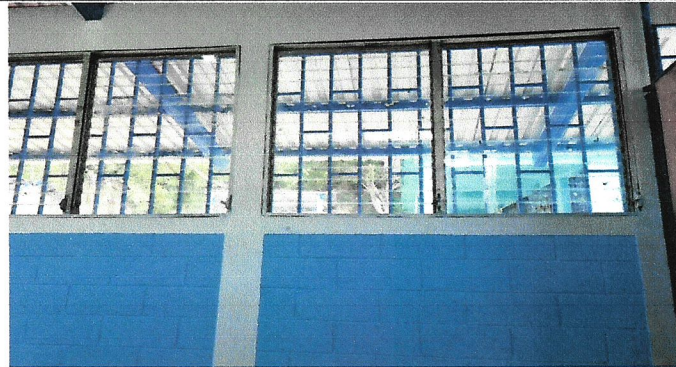
Sus ventanas ya con reposición de vidrios que faltaban.
