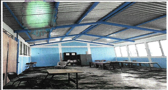
Ya pintadas pintadas la estructura.
