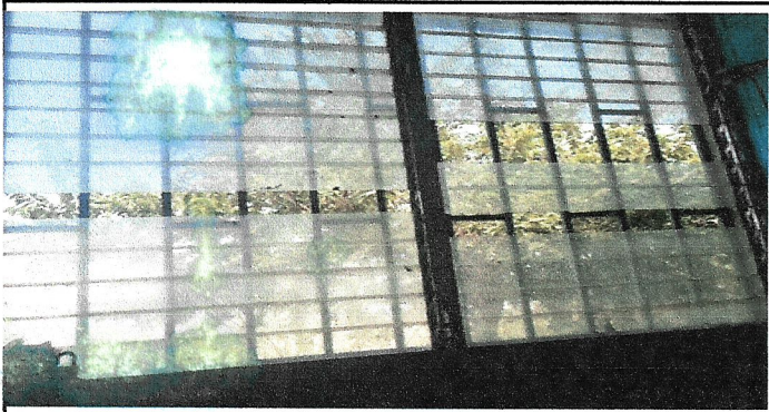
Pintado de balcones y reposición de vidrios.
