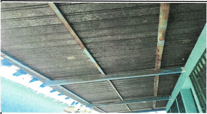
Cambio de techo.
