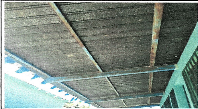
Pintado de estructura
