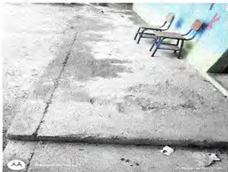
Foto1: Sustrucción de piso de concreto, por piso antideslizante.
