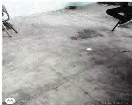
Foto 3: Sustrucción de piso de concreto, por piso cerámico.
