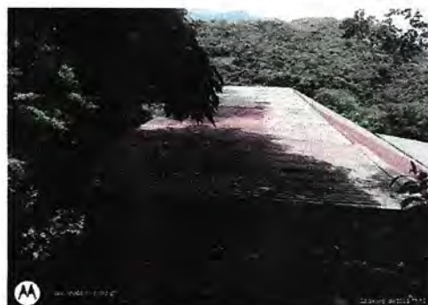
Foto 2: Sustrucción de láminas (oxidadas y con agujeros), por láminas troqueladas.
