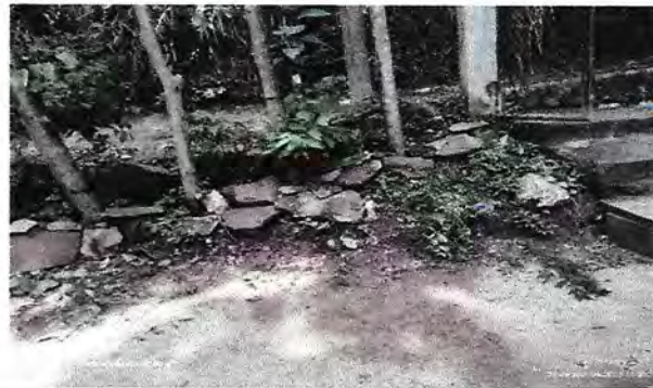
Foto 4: remozamiento de muro perimetral existente con refuerzo de block y malla
