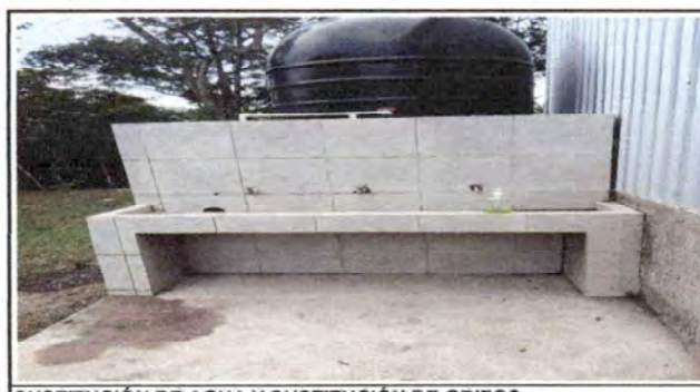
SUSTITUCIÓN DE AGUA Y SUSTITUCIÓN DE GRIFOS.
