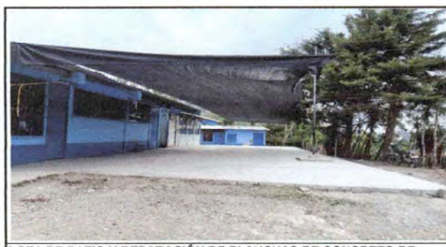
LOZA DE PATIO Y REPARACIÓN DE PLANCHAS DE CONCRETO DE PATIO
