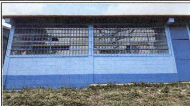
PINTURA EN MUROS EXTERIORES E INTERIORES
