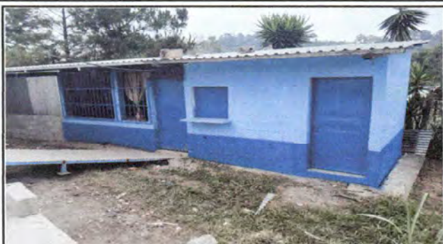
SUSTITUCIÓN DE SOPORTE DE MADERA POR METAL
