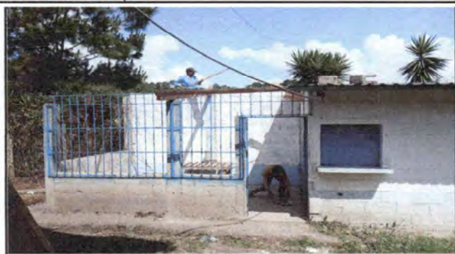
SUSTITUCIÓN DE SOPORTE DE MADERA POR METAL
