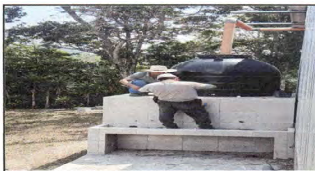
SUSTITUCIÓN DE AGUA Y SUSTITUCIÓN DE GRIFOS.
