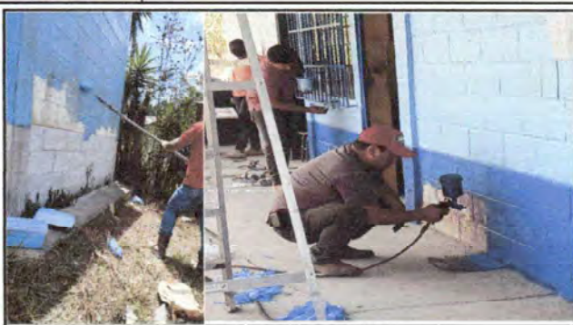
PINTURA EN MUROS EXTERIORES E INTERIORES
