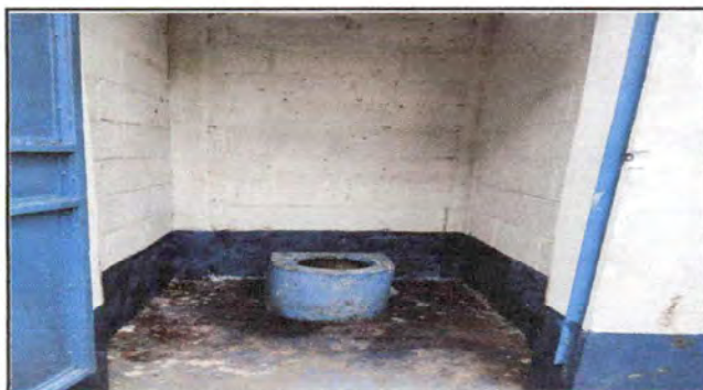
SUSTITUCION DE SANITARIOS CEMENTO POR SANITARIOS LAVABLES DE PORCELANA.
