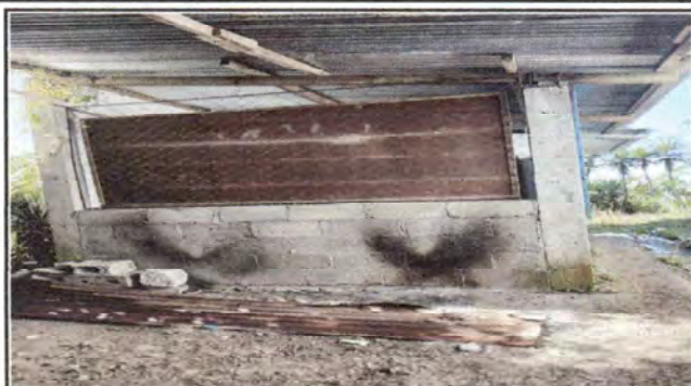
SUSTITUCIÓN DE SOPORTE DE MADERA POR METAL
