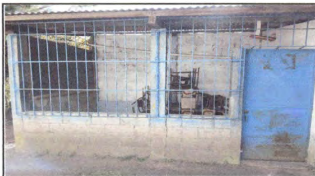
FABRTICACIÓN DE VENTANA, INSTALACION DE LÁMINA TROQUELADA, DESINSTALACIÓN DE LÁMINA ZINC.
