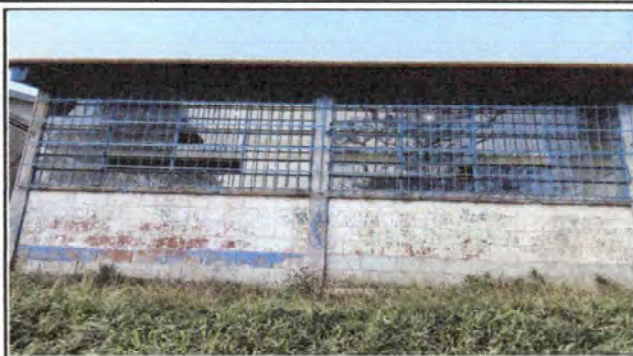
PINTURA EN MUROS EXTERIORES E INTERIORES
