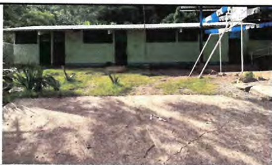
Foto 3: SEGUIMIENTO DE LOSA DE PATIO EN ÁREA DE PASILLO.
