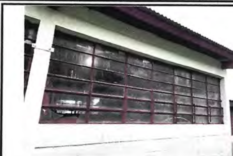
Foto 2: SUSTITUCIÓN DE VENTANAL POR VENTANA DE PVC E INSTALACIÓN DE VALCÓN DE HIERRO DE MEDIA.
