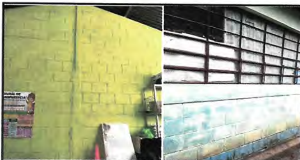
Foto 5: APLICACIÓN PINTURA DE PAREDES INTERIORES Y EXTERIORES
