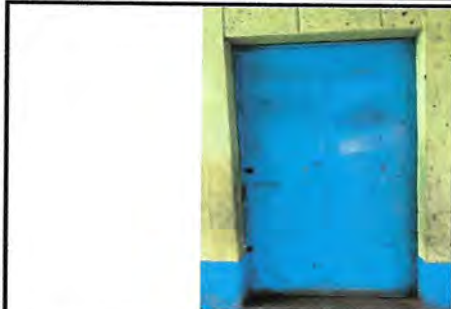
Foto 1: LIJADO, CEPILLADO Y APLICACIÓN DE PINTURA EN PUERTAS DE 1 X 2 M.
