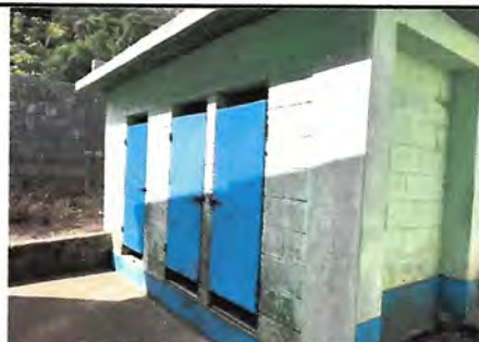
Foto 6: LIJADO, CEPILLADO Y APLICACIÓN DE PINTURA EN PUERTAS. PINTURA EN LAS PAREDES
