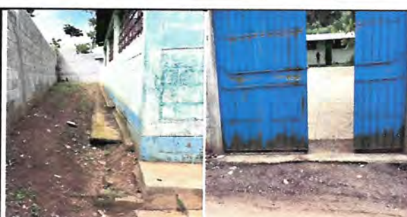
Foto 4: REPARACIÓN DE BANQUETA, CUNETAS Y RAMPA DE ACCESO
