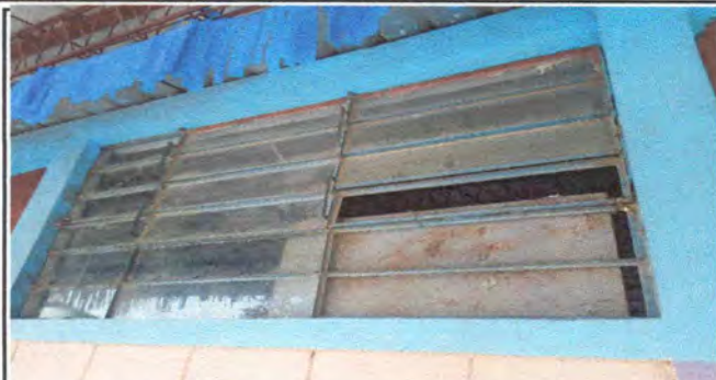
Foto 1: COLOCACION DE BALCONES Y VENTANAS CORREDIZAS DE PVC
