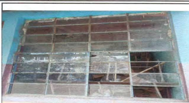
Foto 2: COLOCACION DE BALCONES Y VENTANAS CORREDIZAS DE PVC
