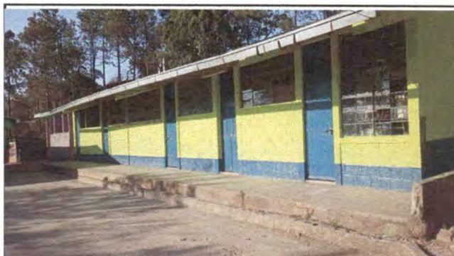
Foto 4: COLOCACION DE BALCONES Y VENTANAS
