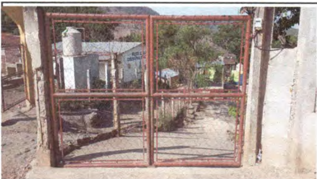
Foto 3: COLOCACION DE PORTON DE METAL ENTRADA PRINCIPAL
