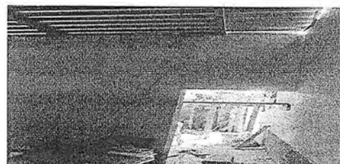
REPARACIÓN DE 15 METROS DE LARGO POR 5 METROS DE ANCHO DE TECHO DE LÁMINA, POR LÁMINA TROQUELADA.
