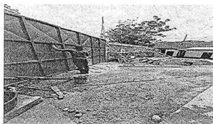
FABRICACIÓN E INSTALACIÓN DE PORTÓN DE INGRESO.
